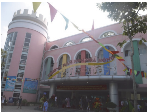
写真 3：ホアホン幼稚園のエントランス
